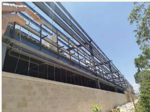
04 • Montaje de estructura metálica y cubiertas
