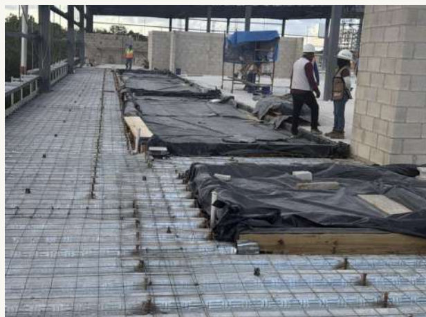
06 • Cimbrado especializado en áreas frigoríficas
