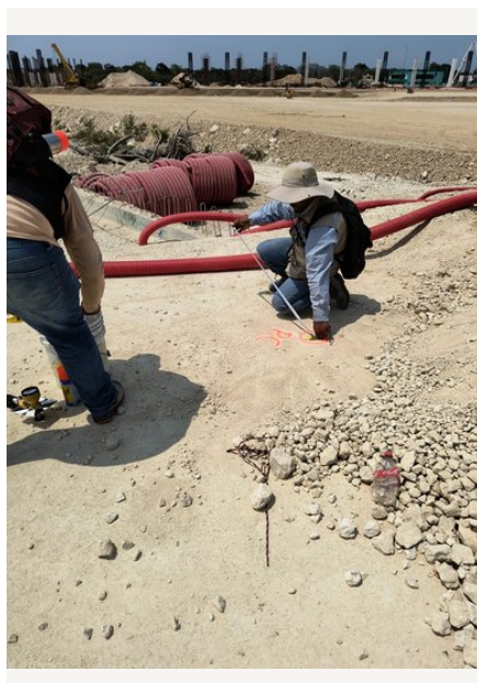
Trazo, nivelación y ductería.
