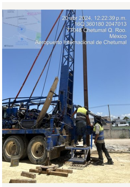
Perforación con equipo montado en camión.
