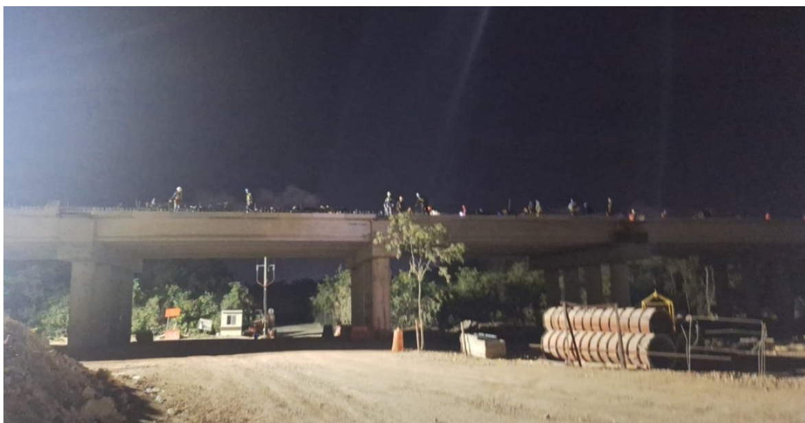
Trabajos nocturnos en el viaducto elevado.
