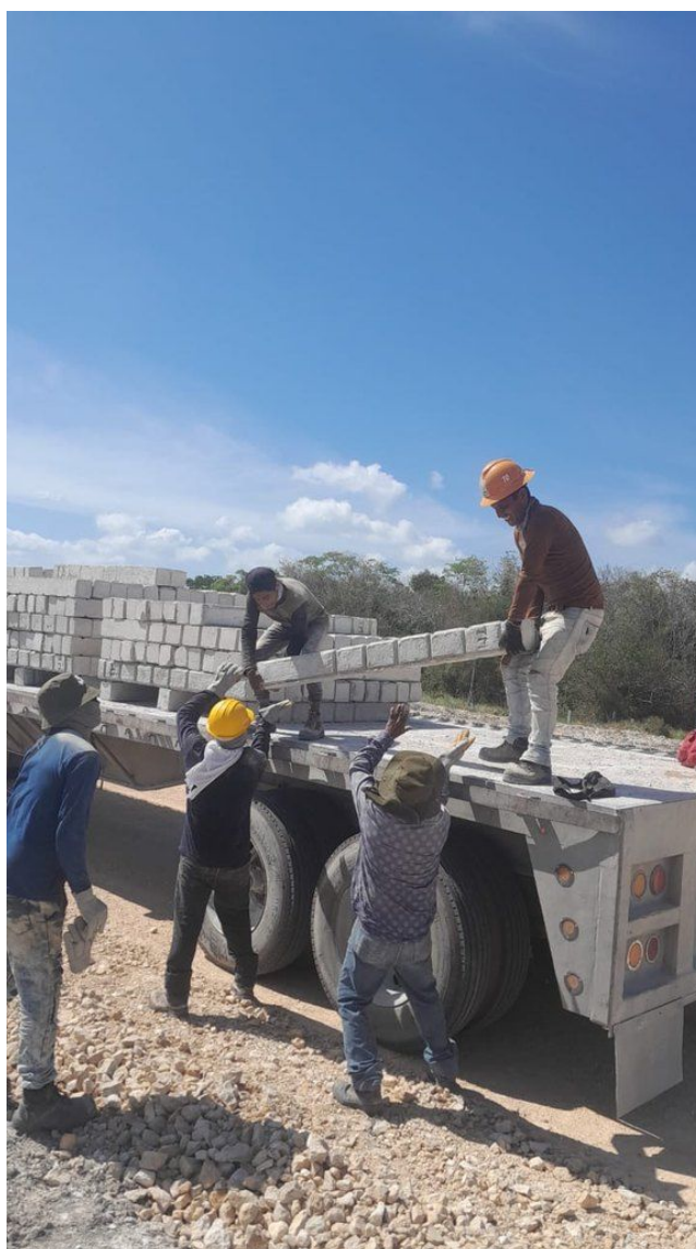
Descarga de postes en el frente de obra.
