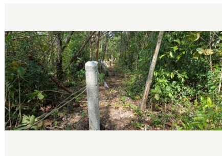
Poste para delimitación del DDV.
